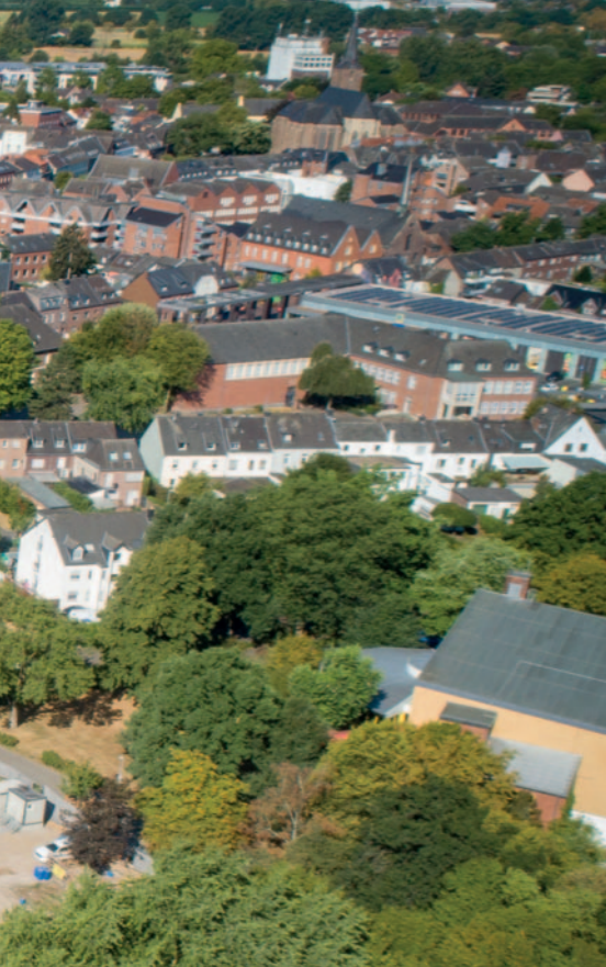
Vom alten FSG-Schulgebäude ist nichts mehr zu sehen. In den kommenden Tagen werden die Abrissarbeiten final abgeschlossen. Fotos: Terhorst (4) Seybert (1)
