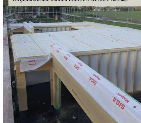
Durch die Holzbauweise konnten die einzelnen Wand- und Deckenelemente vergleichsweise schnell montiert werden. Foto: GBG
