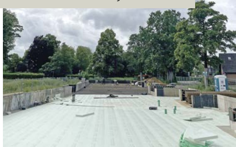
Ein Bild aus Juni, nachdem die Bodenplatte schon teilweise gegossen wurde und die ersten Dämmarbeiten erfolgt sind. Foto: GBG
