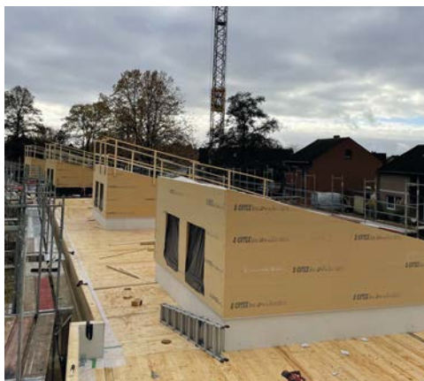
Durch die Holzbauweise konnten die einzelnen Wand- und Deckenelemente vergleichsweise schnell montiert werden. Foto: GBG
