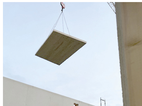
Durch die Holzbauweise konnten die einzelnen Wand- und Deckenelemente vergleichsweise schnell montiert werden. Foto: GBG
