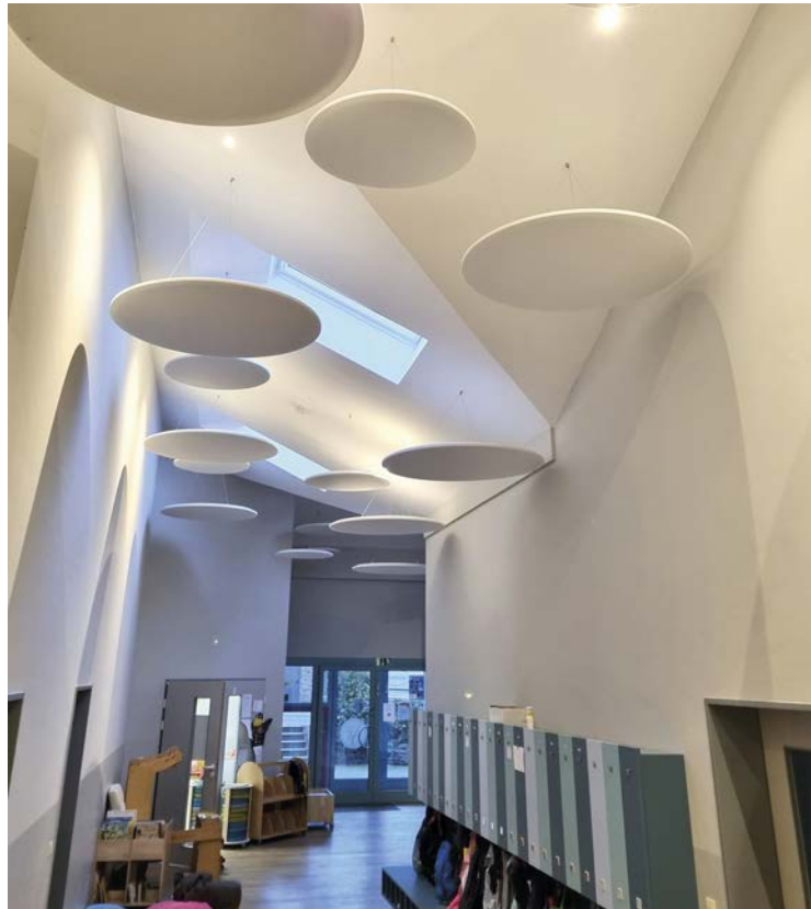
Bild vom Kindergarten Eskenspfad in Walbeck. Schallschutz - Deckensegelmontage
