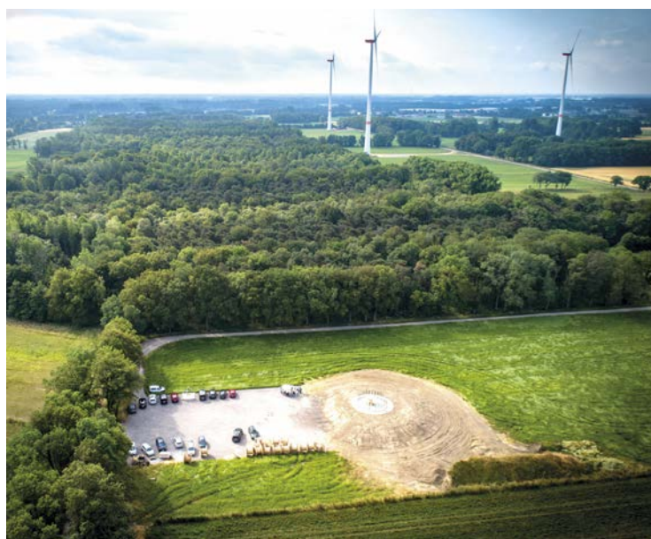
Ein Blick aus der Vogelperspektive auf die derzeit im Bau befindliche Windkraftanlage nahe der Steinstraße in Pont mit Blick in Richtung Straelen Fotos: beide Stadt Geldern/Seybert
