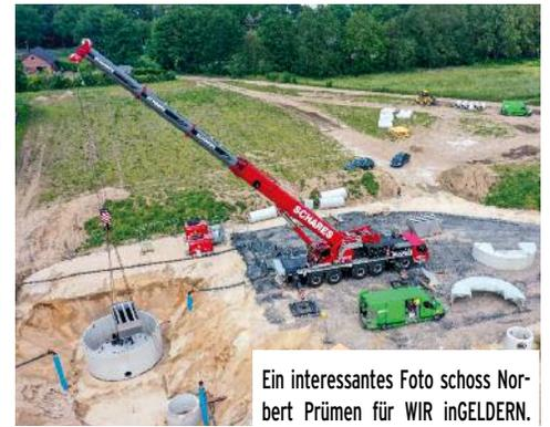
Ein interessantes Foto schoss Norbert Prümen für WIR in GELDERN. Hier ist deutlich zu sehen, wie das Herzstück der Anlage mit einem Schwerlastkran in ein Sammelbecken des Regenwassersystems im Gewerbegebiet „Am Pannofen - West“ eingesetzt wird.
