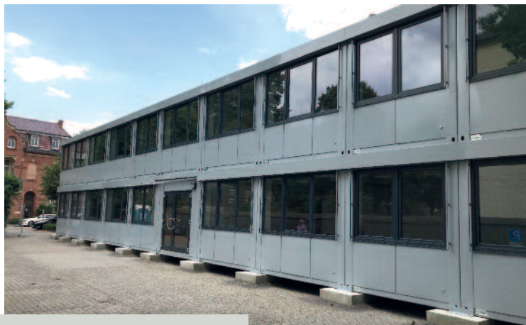
Fertig zum Einzug: Die Container am Westwall werden zur neuen Heimat der Zehntklässler der Realschule An der Fleuth.
